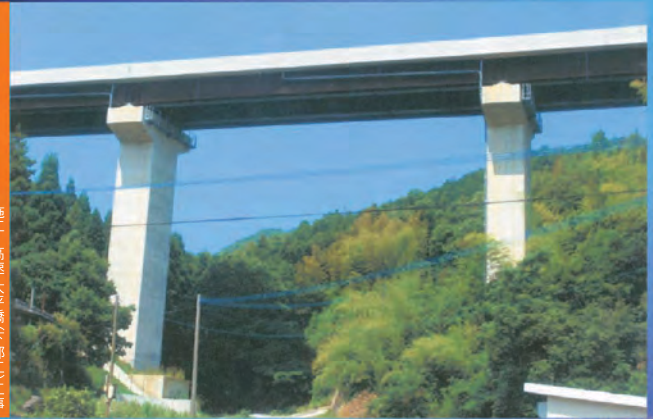
施工 高速大平橋下部工工事
