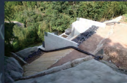
施工 太田川(下部)工事
