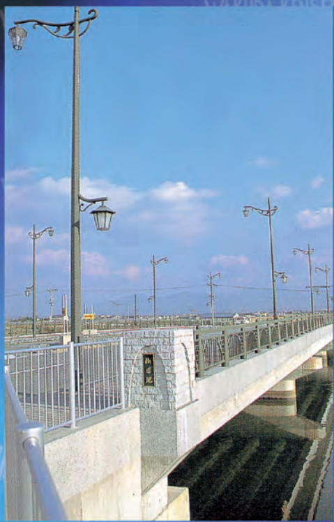
施工 単県特定港湾建設工事
