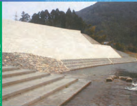
施工 合志野地区築堤護岸工事
