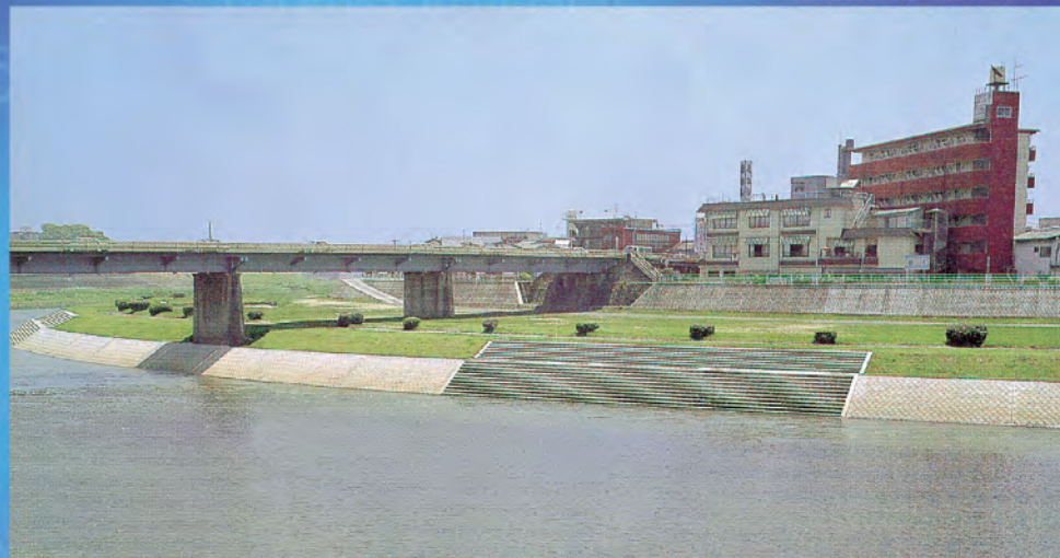
施工 大江護岸根固災害復旧その2工事
