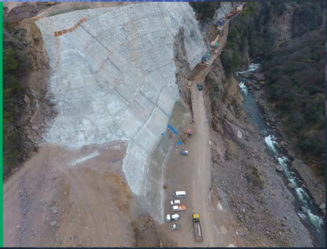
(阿蘇) 平成28年度災害復旧村道橋の木く立野線戸下地区法面掘削工事
