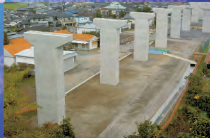
施工 田浦橋高架橋(下部)工事
