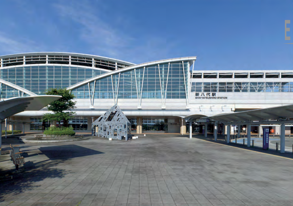
施工 新八代駅
