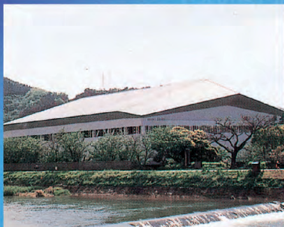
施工 水俣市立体育館
